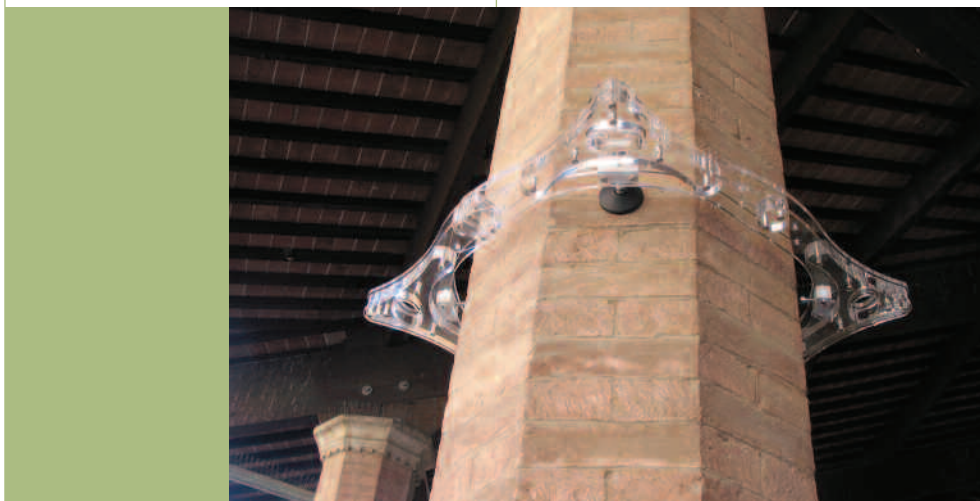
Fig. 10 - Questo crea un pacchetto molto leggero di 3,5 cm con sufficiente inerzia di forma da sopportare le sollecitazioni a cui viene chiamato a rispondere.
