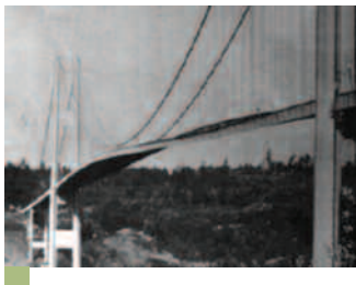
Fig. 6 - Takoma Bridge, onda di svergolamento dovuta al vento.
