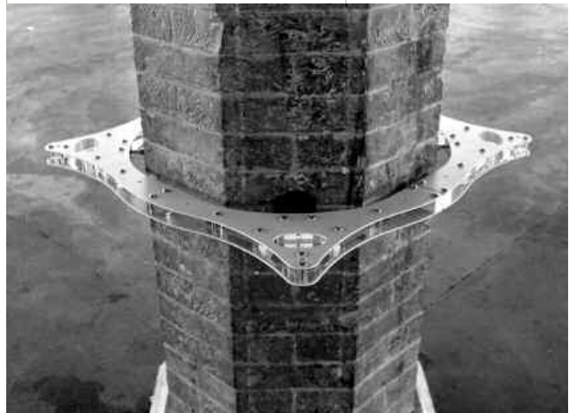
Fig. 8 - Coppie di sottili bracci in plexiglas, incernierati anch'essi agli anelli, impediscono poi con la loro leva qualsiasi rotazione dei singoli pannelli. In questo caso (date le dimensioni dei pannelli), è stato sufficiente montarne i braccetti nella sola zona alta.
