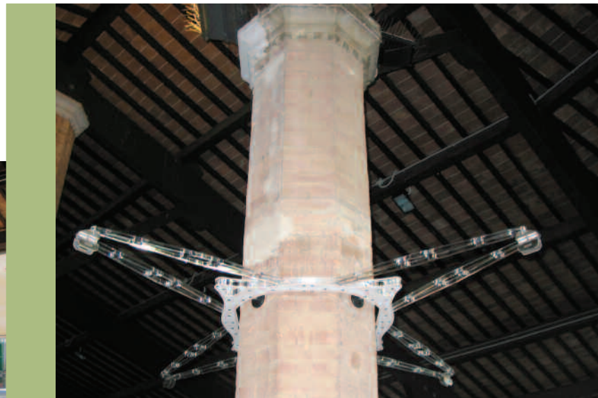
Fig. 11 - Andando a serrare i piedini registrabili che si trovano tra anello e pilastro, si riesce a bloccare alla quota desiderata la struttura senza danneggiare le colonne.
